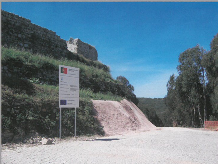
Aspecto geral da última intervenção do IPPAR no Castelo de Aljezur
